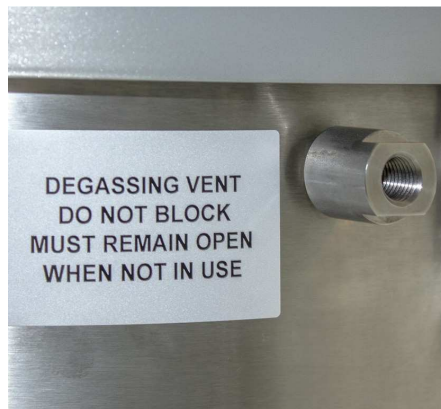
発生ガス排気弁
